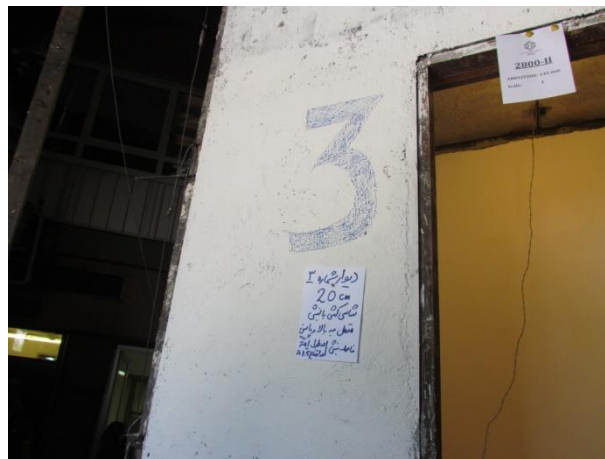
شکل (پ ۱-۱۵) نمایی از دیوار شماره (۳)
