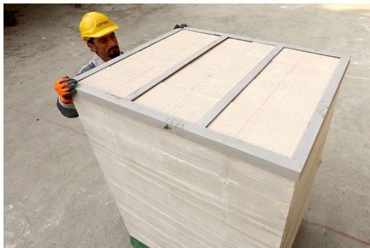
شکل (۱-۳) حمل پالت‌های انتقال بلوک‌های AAC
