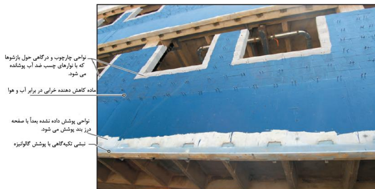
شکل ۵-۱۸ استفاده از ماده مخصوص کاهش‌دهنده خرابی در برابر آب و هوا قبل از اجرای نمای آجری
