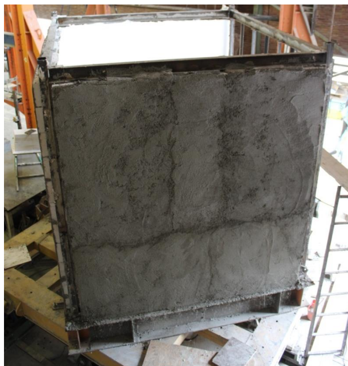
شکل (پ ۱-۲۰) نمایی از دیوار شماره (۲) اجراشده در قاب
