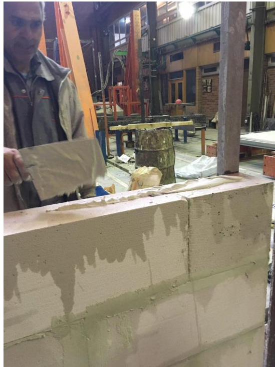
شکل (پ ۱-۹) اجرای ردیف‌های بعدی بلوک چینی
