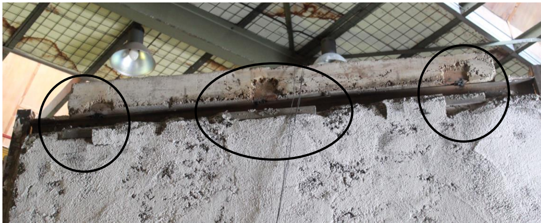
شکل (پ۱-۲۱) نمایی از اتصال دیوار شماره (۲) به تیر فوقانی
