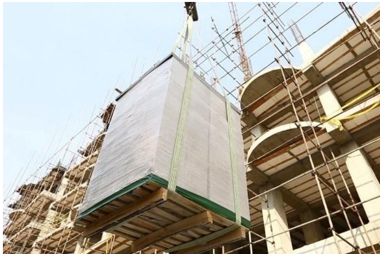
شکل (۴-۱) حمل پالت‌های انتقال بلوک‌های AAC
