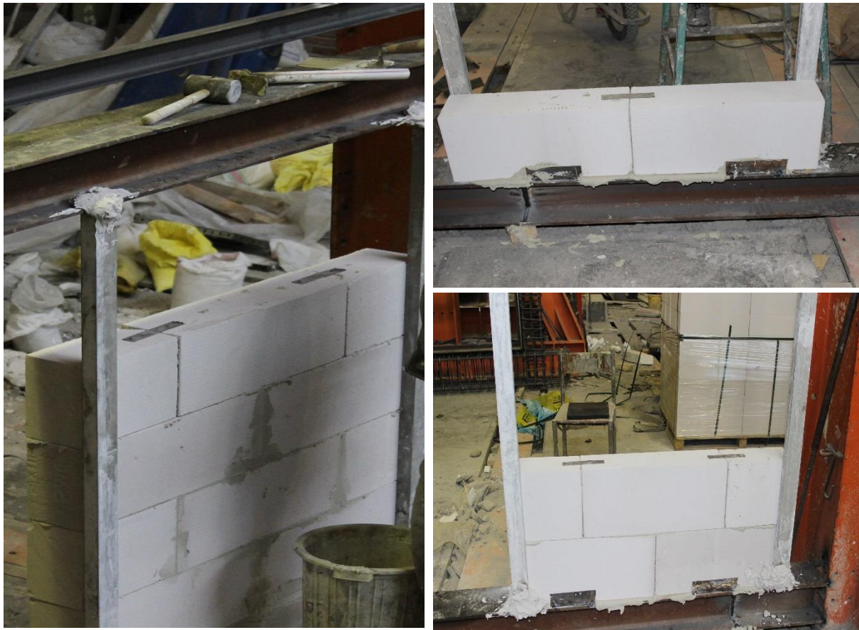
شکل (پ ۲-۴) جزئیات ساخت دیوار AAC
